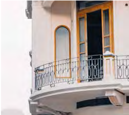
Gemauerter Sockel & geschmiedetes Metallgeländer
